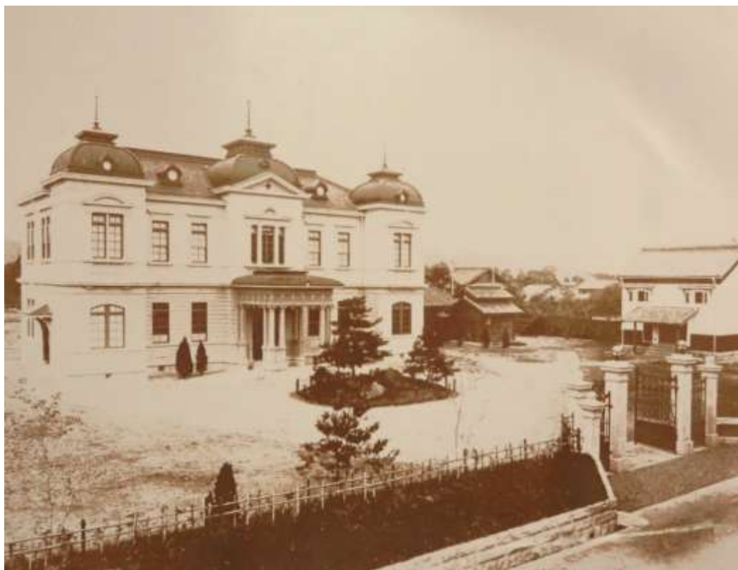
日本赤十字社岩手支部庁舎(盛岡市内丸・明治 42 年 8 月)
