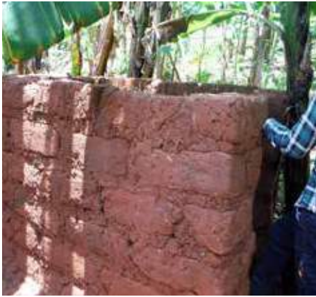
屋根も扉もない村のトイレ
