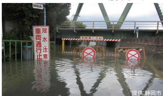
▼冠水したアンダーパス
