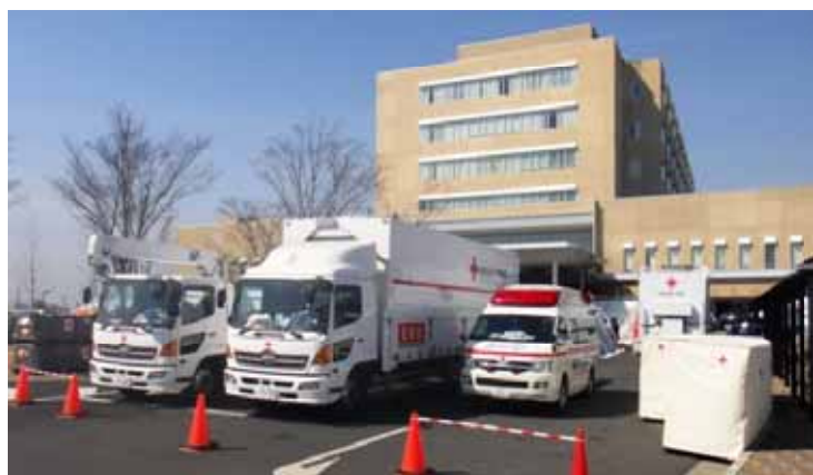
宮城県内の医療活動拠点となった石巻赤十字病院。 平成18年に移転新築された。建物は免震構造。 病院職員や職員の家族にも被災された方は多い。 (平成23年3月14日)
