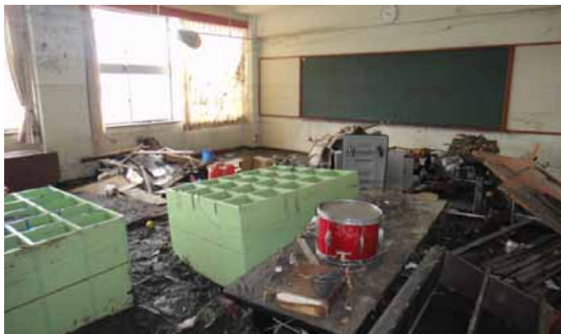
被災地の学校の教室 (平成23年3月15日石巻市内)
