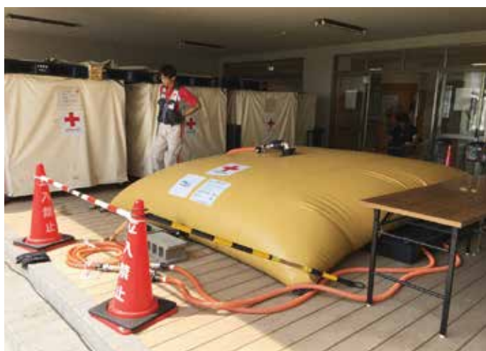
設置が完了した国際ERU給水資機材
