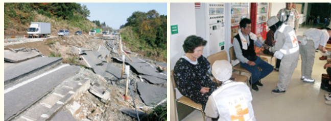
平成16年 新潟県中越地震 (多数の道路が崩落。小千谷などに救護班を派遣。)
