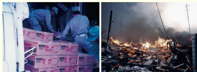
平成7年 阪神・淡路大震災 (震源に近い神戸市の被害は甚大であった。多くの救援物資を搬送。)
