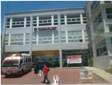
新設されて日の浅い フィリピン赤十字和ガボ市支部社屋
