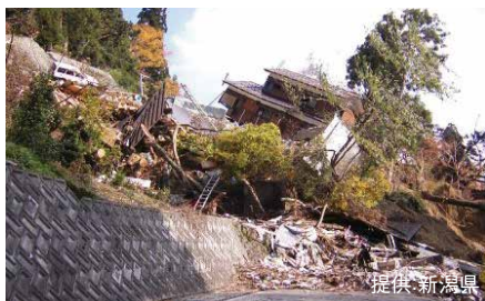
提供:新潟県 新潟県中越地震(2004年)
