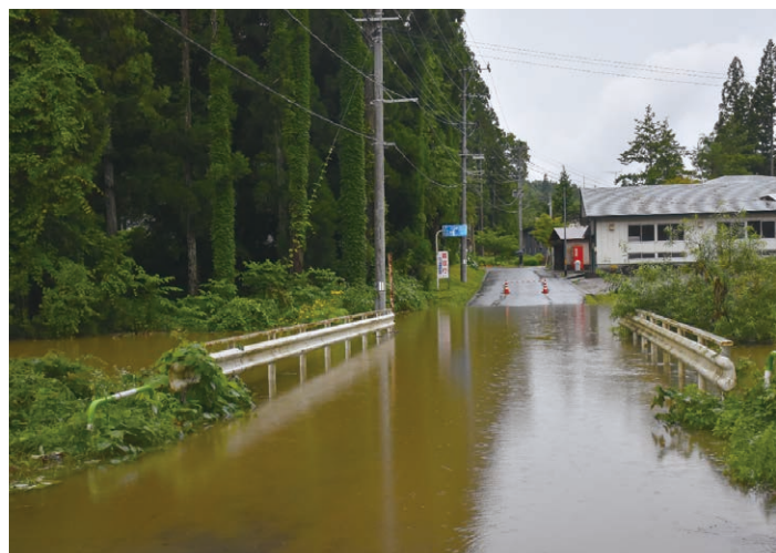
大沢郷下戸川公民館に向かう途中、橋が浸水しており巡回を断念
