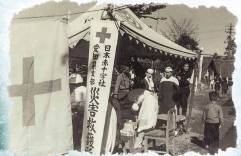
テントを張り、災害救護所を設営
