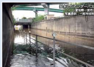
冠水した道路
