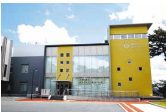
豊川市防災センター
