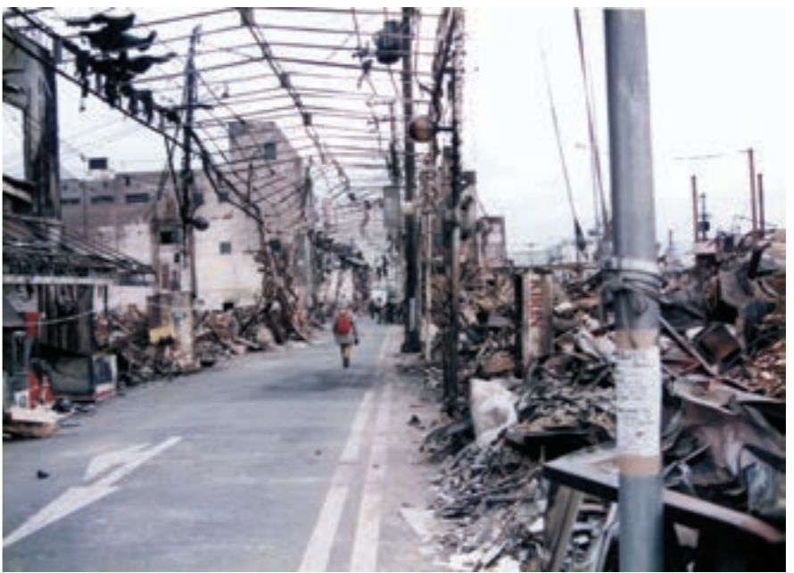
地震による火災で、骨組みだけを残してアーケードが無残に焼け落ちた、神戸市長田区の菅原商店街。
