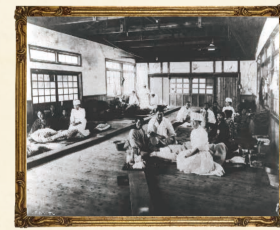
津波被害を受けた館山に設置した日赤千葉支部救護所
