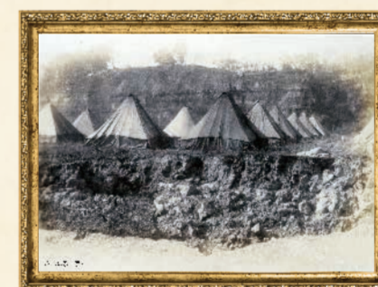
アメリカ赤十字社が設置した、震災により生じた地割れの上に建つ麻布の臨時テント病院
