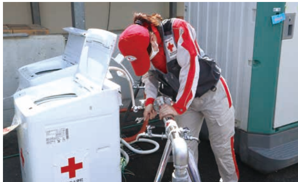
(写真・上) WASHチームで手洗い場の水道を設置する富田さん(右) / (写真・下) 断水している避難所に洗濯機を設置 * [Water, Sanitation and Hygiene] の略。水と衛生の総合的な分野を指し、災害時に安全な水の確保や環境衛生の改善を行う。
