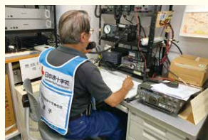
防災センターから無線を使い災害の情報確認をしている。
