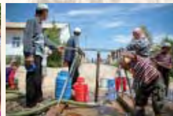
▲ICRCの支援で設置された給水ポイント
