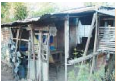
台風被害を受けた住宅
