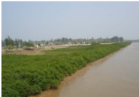
堤防の外側に植林されたマングローブ林
