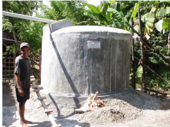
設置された雨水貯水槽
