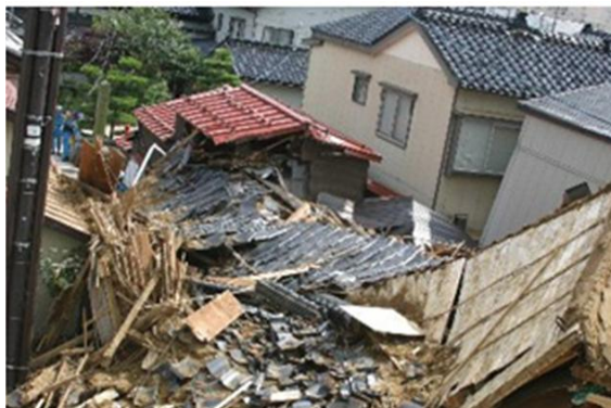
倒壊した家屋(新潟県中越沖地震)
