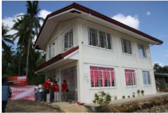
完成した公共施設。1階は保健センター、 2階はコミュニティーセンター
