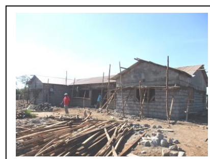
建設中のイシオロ県支部の外観
