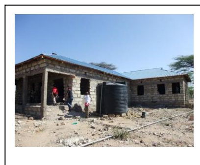
建設中のガルバチューラ県立 病院手術室の外観
