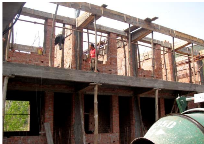
建設中の日赤支援病院(陝西省漢中市城固県)
