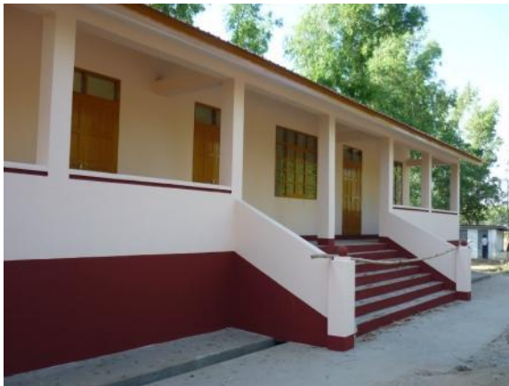
ラプタ地区で完成した校舎。あとは井戸の完成を待つのみ。©ミャンマー赤十字社
