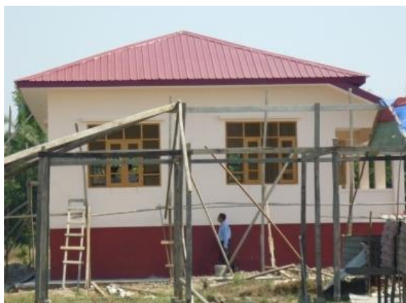
ディディエ地区。防災強化型の校舎となり、高潮、洪水の被害を避けるため、土台の高さは5フィートになりました。©ミャンマー赤十字社
