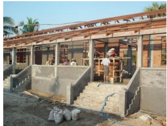
ディディエ地区建設現場。30フィート×90フィートの校舎には、教室までの階段を2つ設置します。
