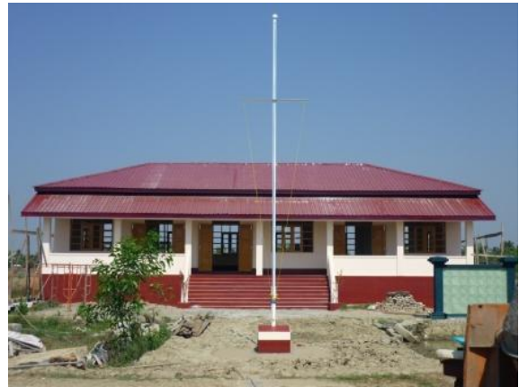
ディディエ地区、完成間近の校舎。校舎前の道は、雨季に備えて、住民の手により0.6mの高さに盛り土されました。©ミャンマー赤十字社
