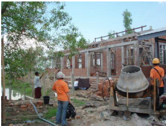
チャイラット地区建設現場。オレンジ色のシャツを着ているのは、ミャンマー赤十字社職員。
