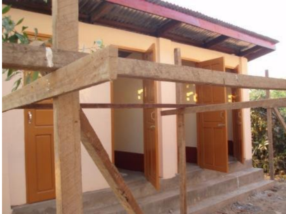
ディディエ地区、トイレ建設の様子。トイレはすべて、校舎の離れに建設されます。©ミャンマー赤十字社
