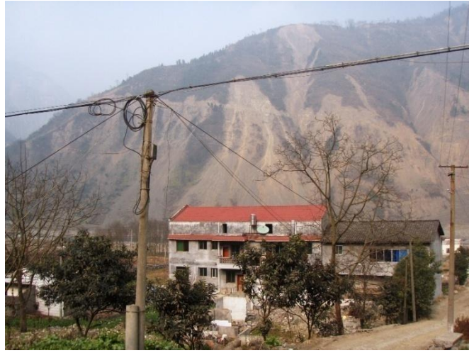
激震地の北川県。地震による崖崩れで山がはげている
