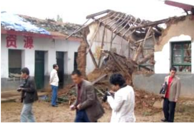
倒壊した農村の小学校(甘肅省隴南市徽県)
