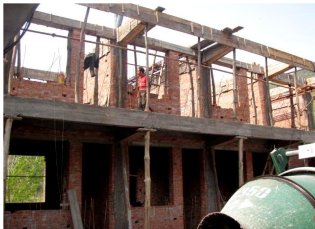
建設中の日赤支援病院(陝西省漢中市城固県)
