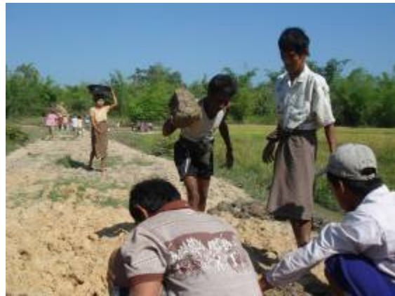
CFW 事業：住民が協働して道路補修など村のインフラ整備を実施 ©IFRC
