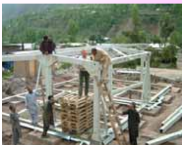
住宅の骨組みを建てる
