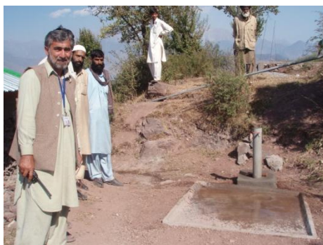
（再建された給水スタンド（カシミール州））
