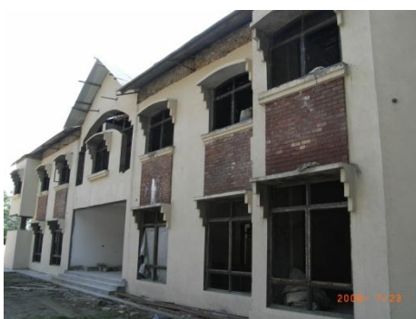
（建設中のショハル・ナジャフ・カーン男子中学校（北西辺境州））
