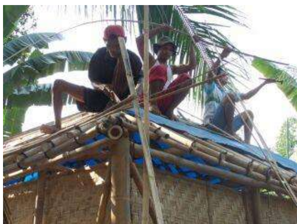
地域住民が協力して仮設住宅を建設
