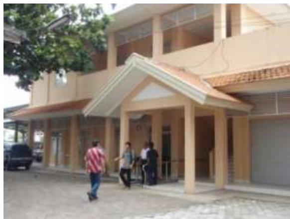
耐震構造で再建されたインドネシア赤十字社ジョグジャカルタ支部
