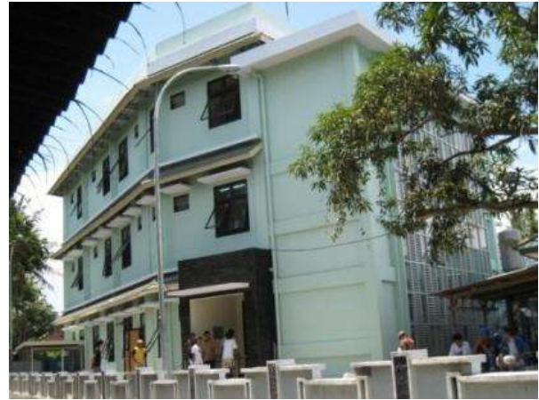
19床の入院病棟を備えて完成した3階建ての病院
