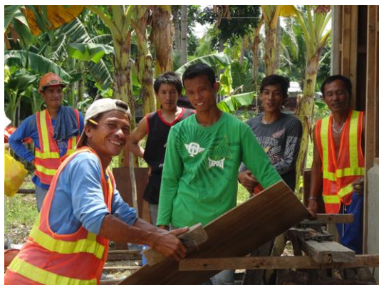
住宅の再建工事の様子
