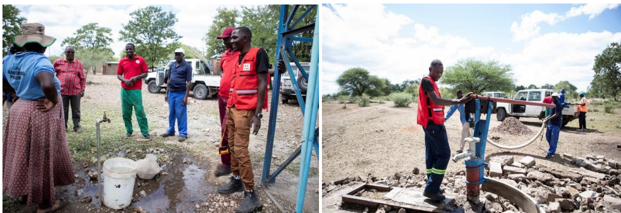
壊れて放置された水源の修復に取り組んでいる様子 ©IFRC
