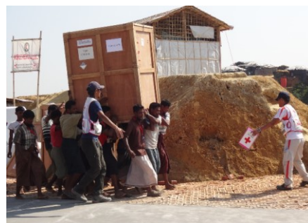
整地が終わった建設予定地に ERU 資機材を運ぶ日赤チーム
