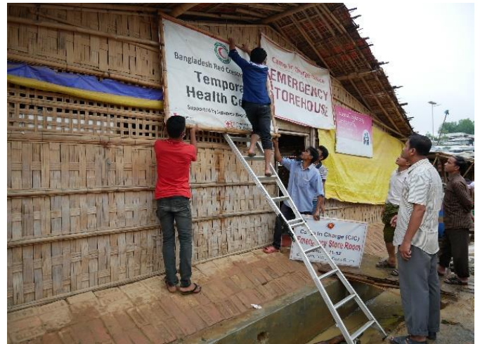
強い雨風によって壊れた診療所の看板をボランティア自前で修復
