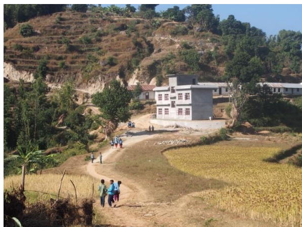
日赤が支援し、昨年の大地震で避難所として活躍したウダヤプール郡リンパタール村の学校
